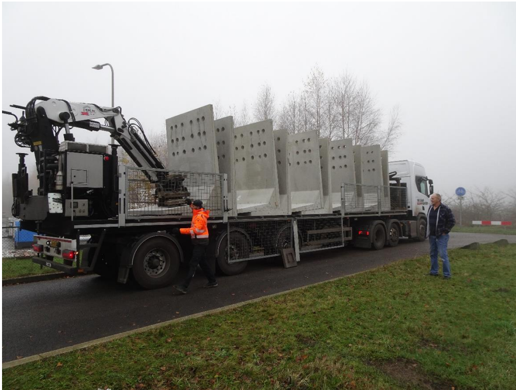
Foto 1 Lossen van de betonelementen
