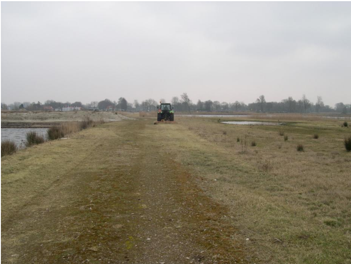
Het verwijderen van riet op het bouwterreintje
